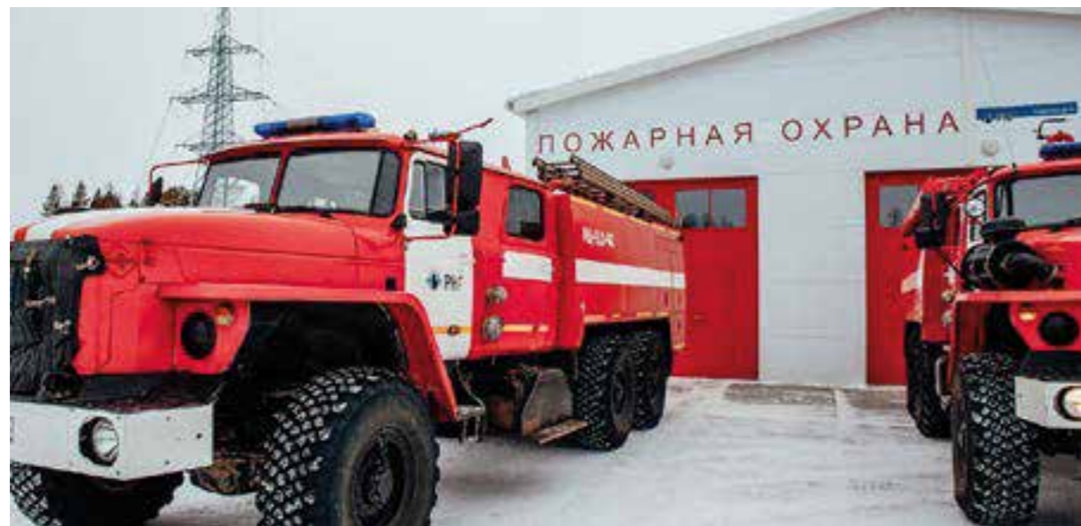
На фото Пожарная служба АО «РНГ»
